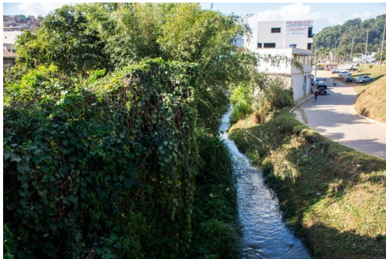
Figura 3.1 - Rio Pardo – trecho 2, na sede do município de Ibatiba.
