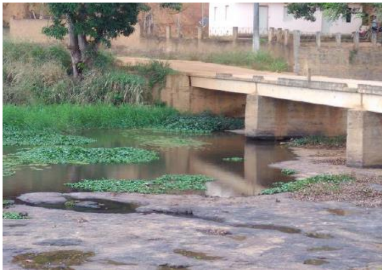
Figura 3.9 - Rio Quinze de Novembro – Trecho 11, na interseção com a rodovia ES-137, à margem da mancha urbana da comunidade de Santo Antônio do Quinze.
