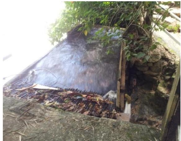
**Figura 23 – Tomada de água da micro usina hidrelétrica (Alfredo Chaves).**
