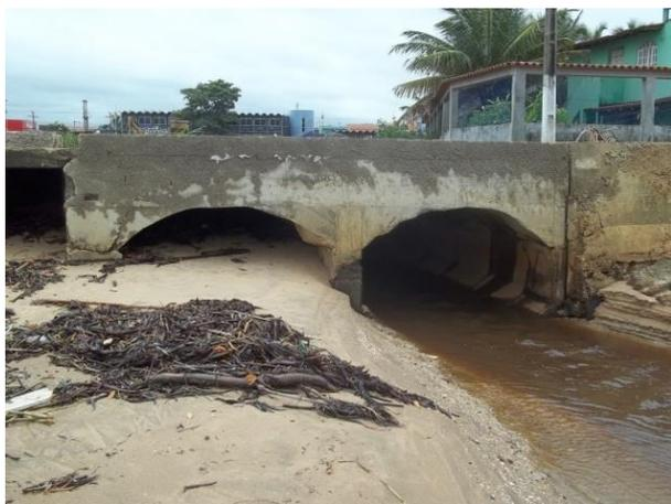
**Figura 4 – Galeria de água pluvial do município de Anchieta com problemas de assoreamento.**
