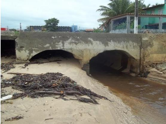
**Figura 42 – Vista da galeria de água pluvial do município de Anchieta com problemas de assoreamento.**
