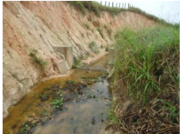
Figura 5.5 – Vertedouro e talude sobre o canal do vertedouro com processos erosivos, responsável Artur Arpini Coutinho.
