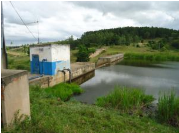
Figura 5.6 – Vista do maciço da barragem, responsável CESAN.
