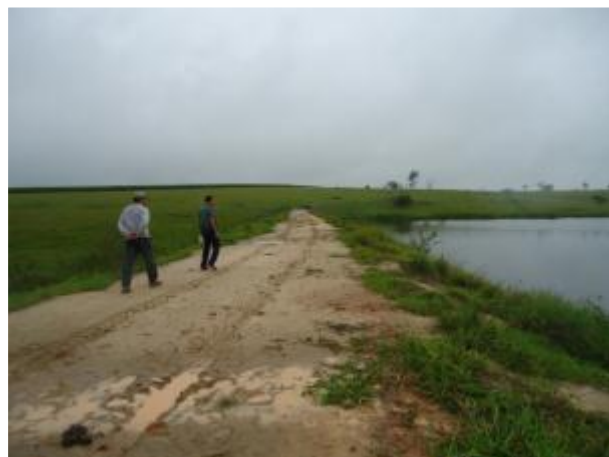
Figura 5.4 – Vista do maciço da barragem e dos taludes, responsável Artur Arpini Coutinho.
