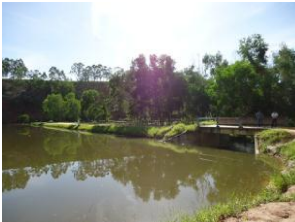
Figura 5.2 - Vista parcial da barragem e vertedouro, propriedade da Prefeitura Municipal de Jaguaré.
