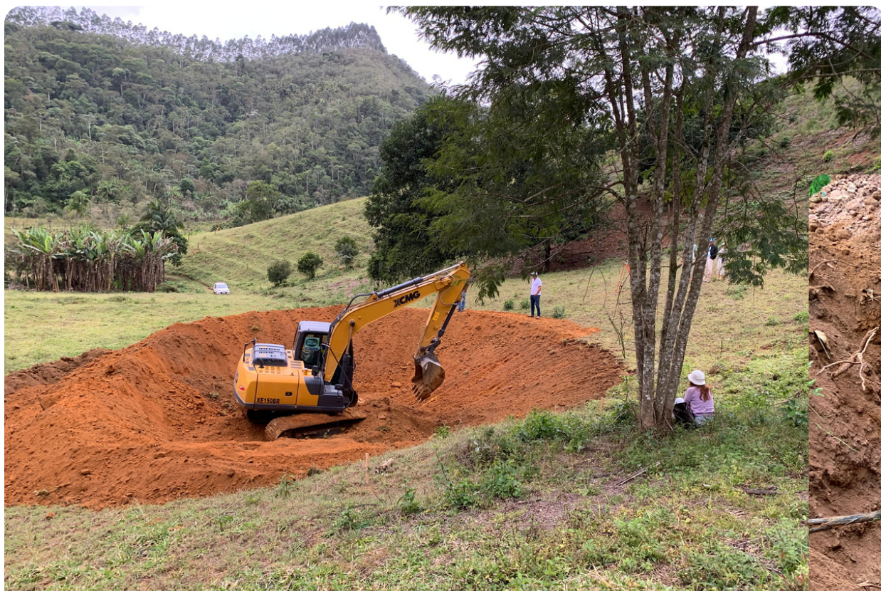
#01 Construção de bacia de infiltração
