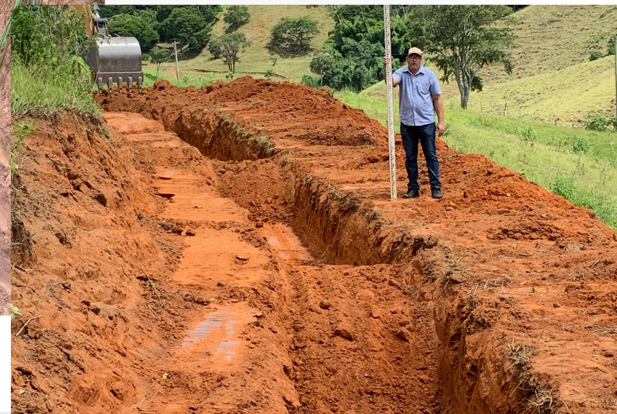
#03 Construção de terraço em nível (cochinho)
