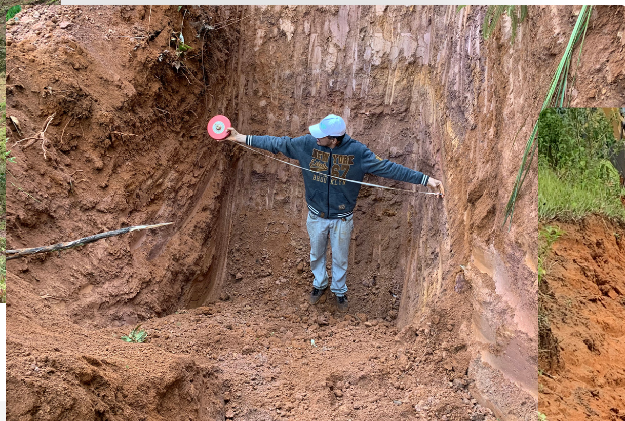
#02 Construção de caixa seca
